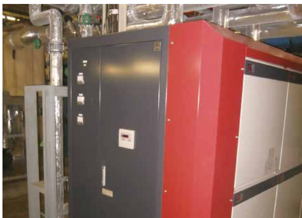
更新した冷凍設備(平塚工場)
