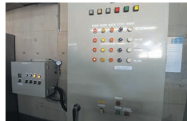
▲富士裾野工場エアークOMPRESSOR運転自動制御改善
