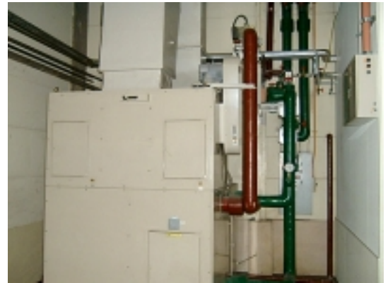
インバーター化の空調機(秦野工場)
